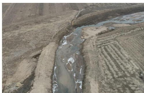
桩号 0+000~1+195 段河道现状
