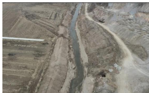
桩号 1+195~2+418 段河道现状
