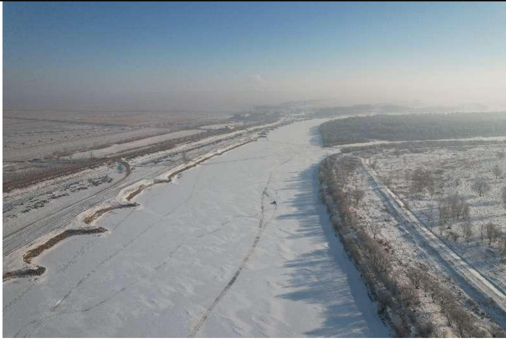
图 3-2 八天地险工实景图 (2/3)
