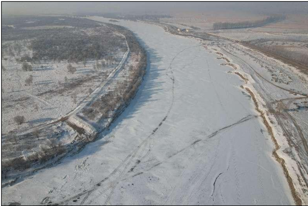
图 3-1 八天地险工实景图（1/3）
