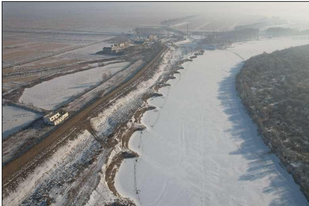
图 3-3 八天地险工实景图 (3/3)
